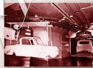
1959年 東洋工業(現・マツダ)F工場
