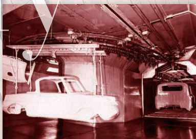
1959年 東洋工業(現・マツダ)F工場
