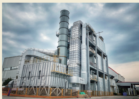
ATTライン処理装置
