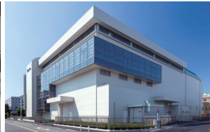
2019 テクニカルセンター開設
