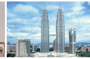
1994 ペトロナスツインタワー (マレーシア)
