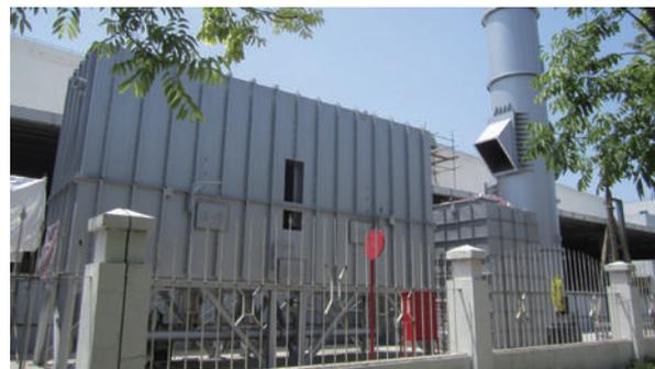
蓄熱式直接燃焼脱臭装置の設置例(上海エリア)
