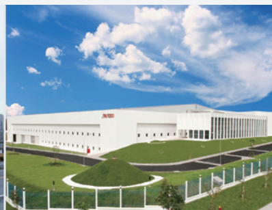
資生堂 ベトナム工場 (ベトナム)
