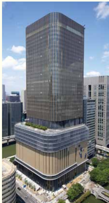
中之島フェスティバルタワー外観
