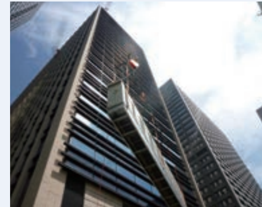
室外機ユニットの揚重作業
