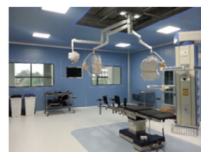
クリーンパネルによる施工施設 (壁・天井・窓・ドア等)
