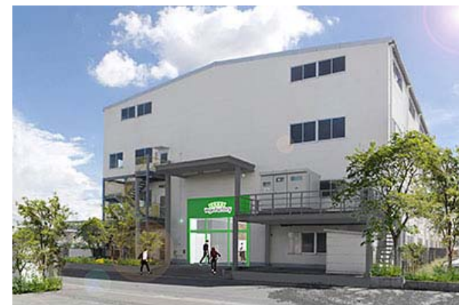
2021年7月竣工予定の杉戸量産実証工場
