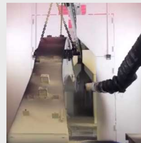
建設機械のフレーム塗装
