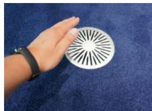
室内全体を包み込むように冷却するユニット（写真左、破線内）の開発や床から局所的な気流を生み出す試み（写真右）など、室内の空間を最大限に利用して実証中
