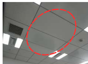
室内全体を包み込むように冷却するユニット（写真左、破線内）の開発や床から局所的な気流を生み出す試み（写真右）など、室内の空間を最大限に利用して実証中
